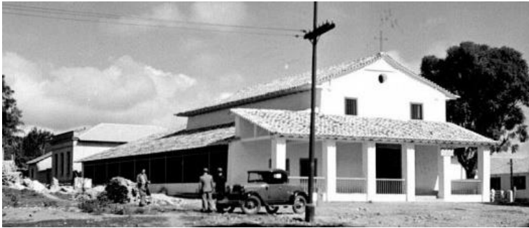
30. Foto do arquiteto Luis Saia na frente da Capela de São Miguel Paulista, durante as obras da primeira restauração em 1940.
